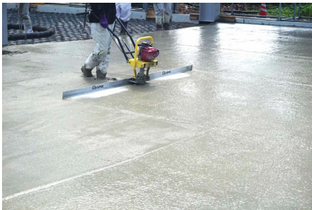
写真2: LCS工法 (再振動締め固め)
