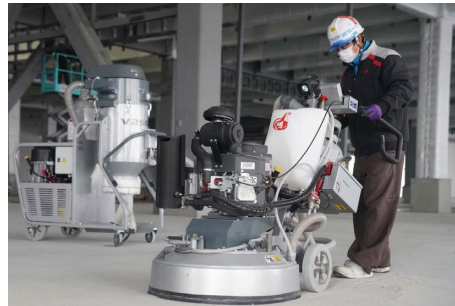
写真10: 研磨機によるポリッシング
