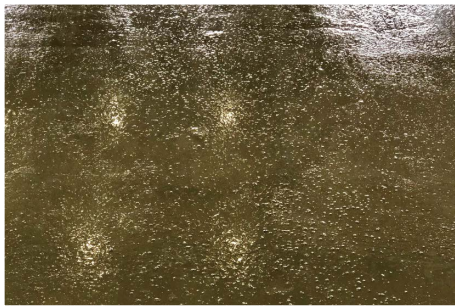
写真3: 再振動による水ミチ、気泡が上昇してきた状況
