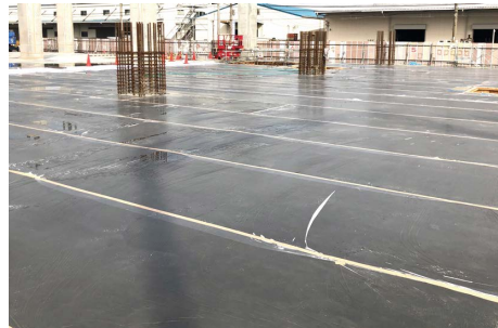
写真8: 仕上げ直後より行う養生
