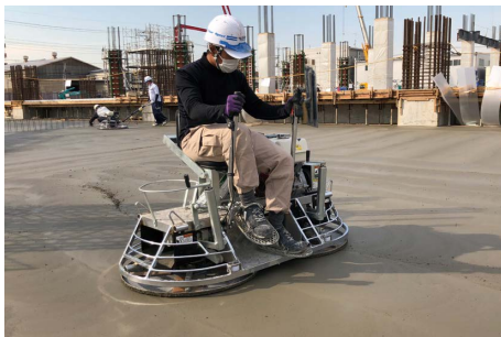
写真5: 騎乗式トロウエルによる表面加圧 (軽量騎乗式170kg〜)
