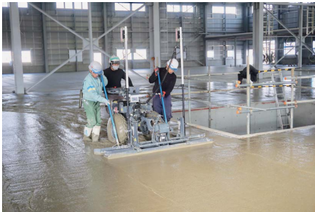
写真1: LCS工法 (レーザースクリードによる均し)
